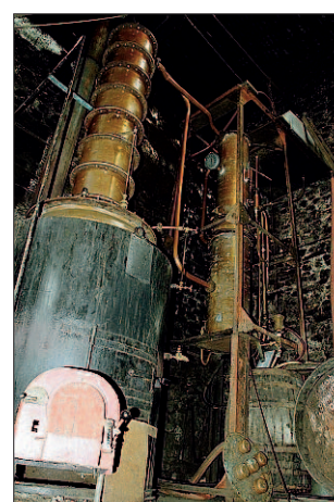
L'alambic à colonnes en cuivre existe à la Moinerie depuis l'origine.
